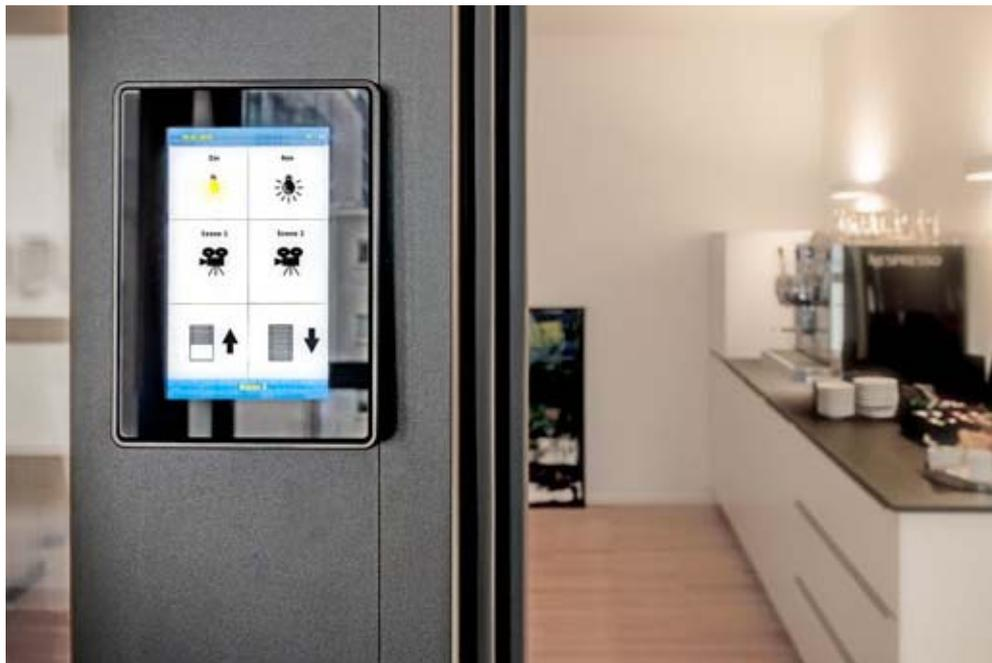
Türseitenteil mit integriertem Bedienelement für Licht, Sonnenschutz und Klimatisierung
