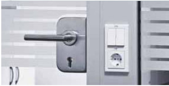
Türzarge mit Aluminium-Türseitenteil für Schalter/Dose
